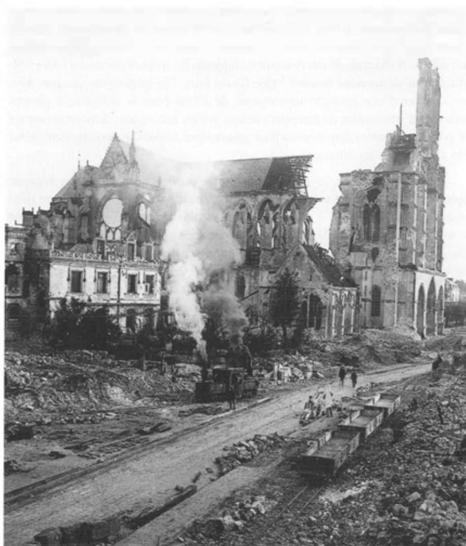
Le déblaiement des ruines (Fond Vergnol)
