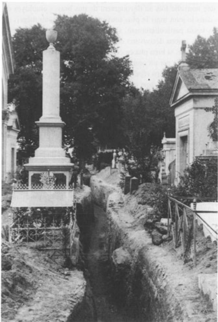
Faubourg St Christophe, tranchée dans le cimetière (Fond BDIC)
