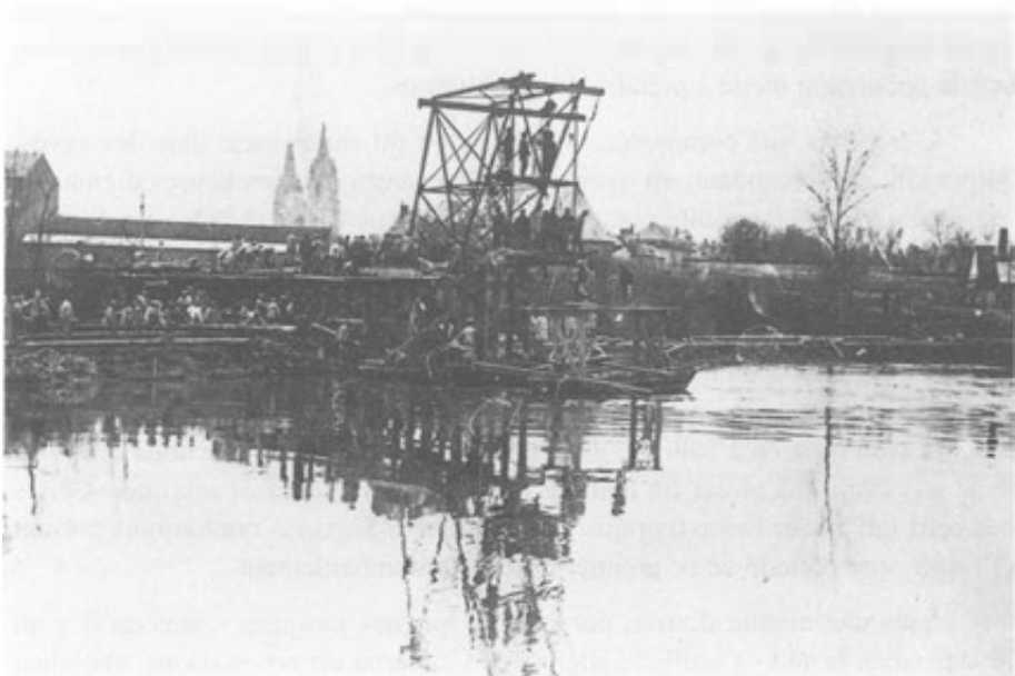
Construction d'un pont sur l'Aisne (Fond BDIC)
