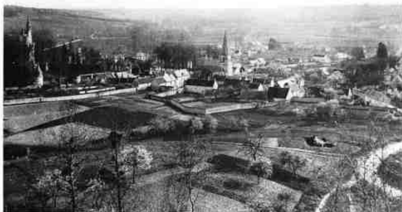
160- Les murs de clôture
