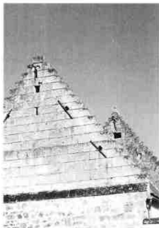
23 - Pignons et ancrés de charpente.
