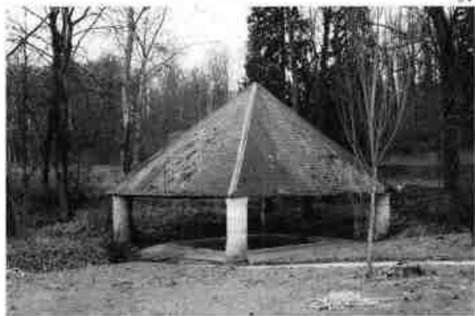
C - Longpont, les piliers d'angle sont en fait des colonnes provenant de l'abbaye. ▶
