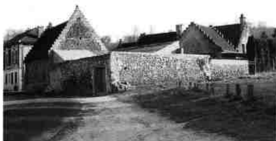
◀ A - mur de Trosly-Breuil.
