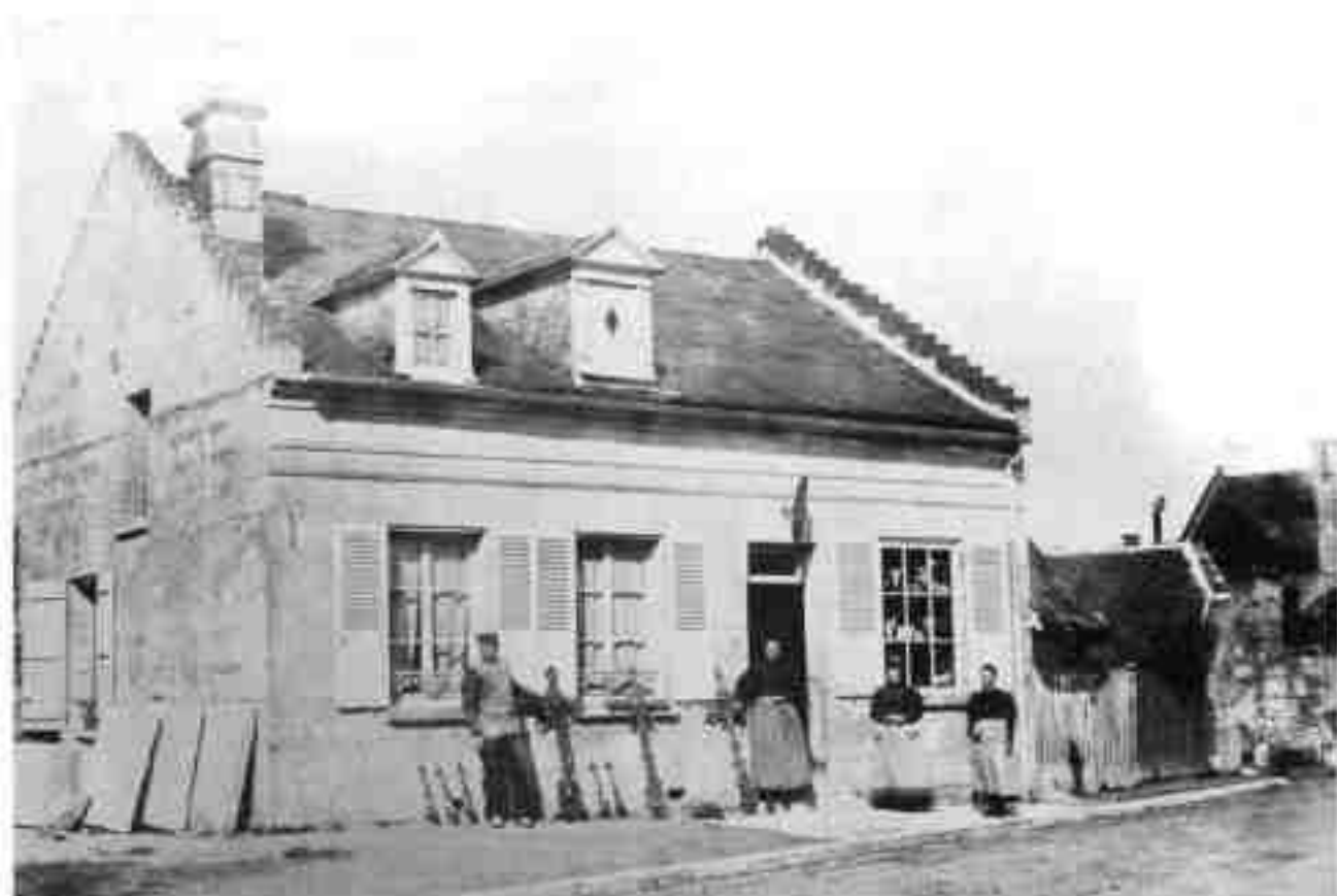
12-1 - Transformation d'une maison, rue du pont Cheminet, rehaussée par O. Henin, à Amblesny en 1898.
