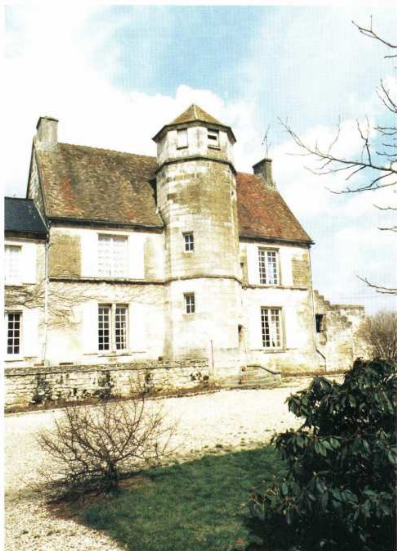
III - 4 - La tourelle d'escalier.
