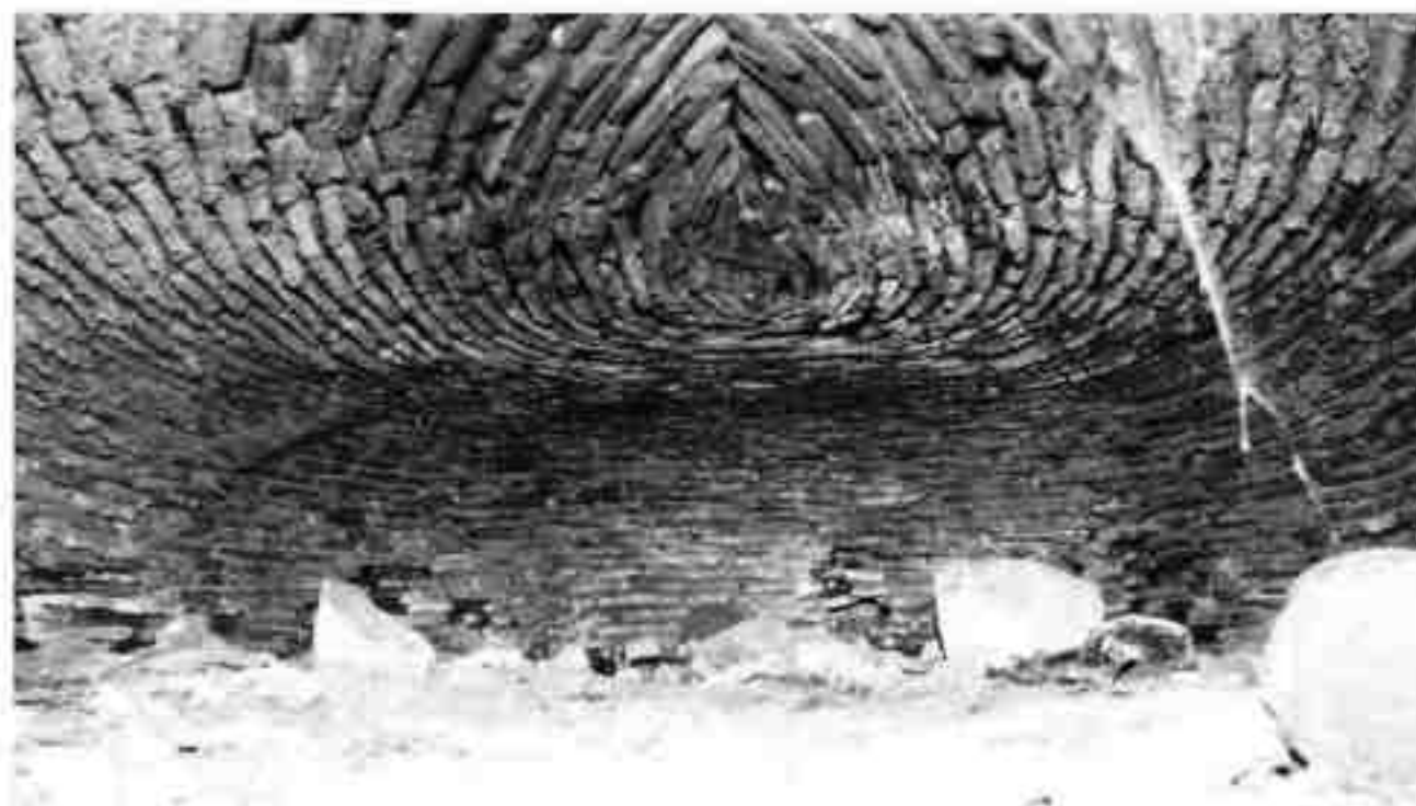
153 - Intérieur d'un four
