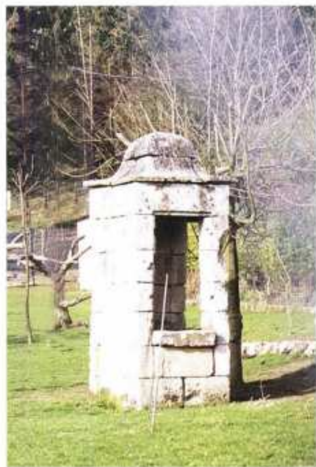
IV - 1-C Puits à Ambleny (le Rollet) ▼
