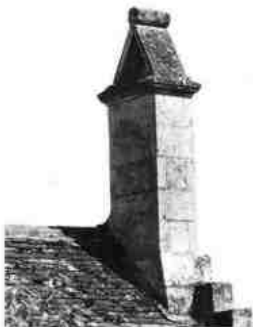
145- Souches de cheminées anciennes
