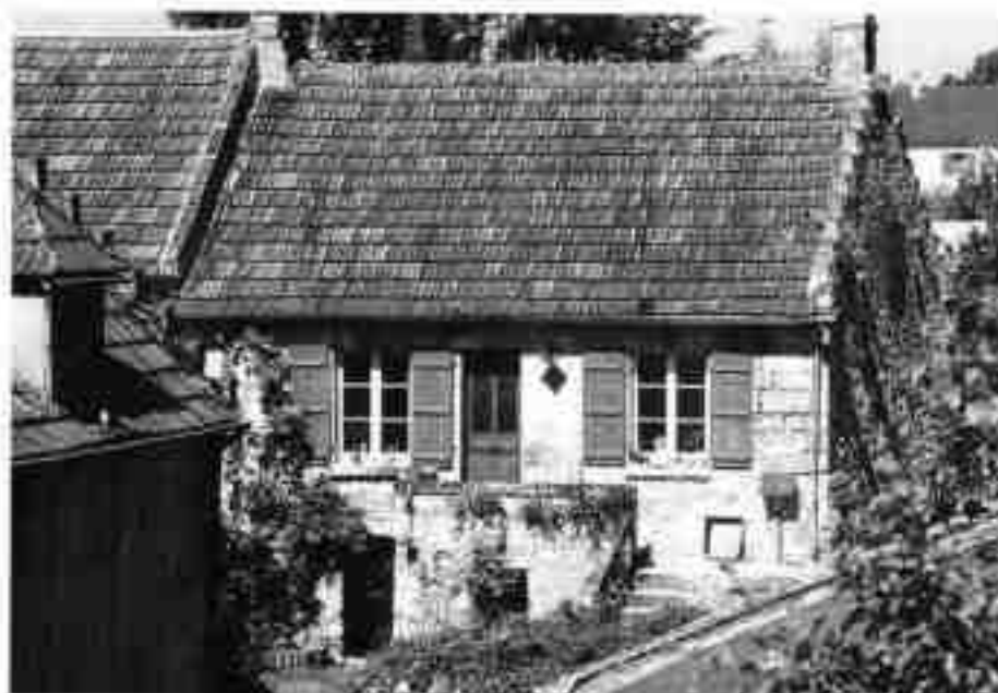
A - Nanteuil-sous-Moret, maison d'artisan. L'atelier est construit dans le prolongement ◀ à gauche.
