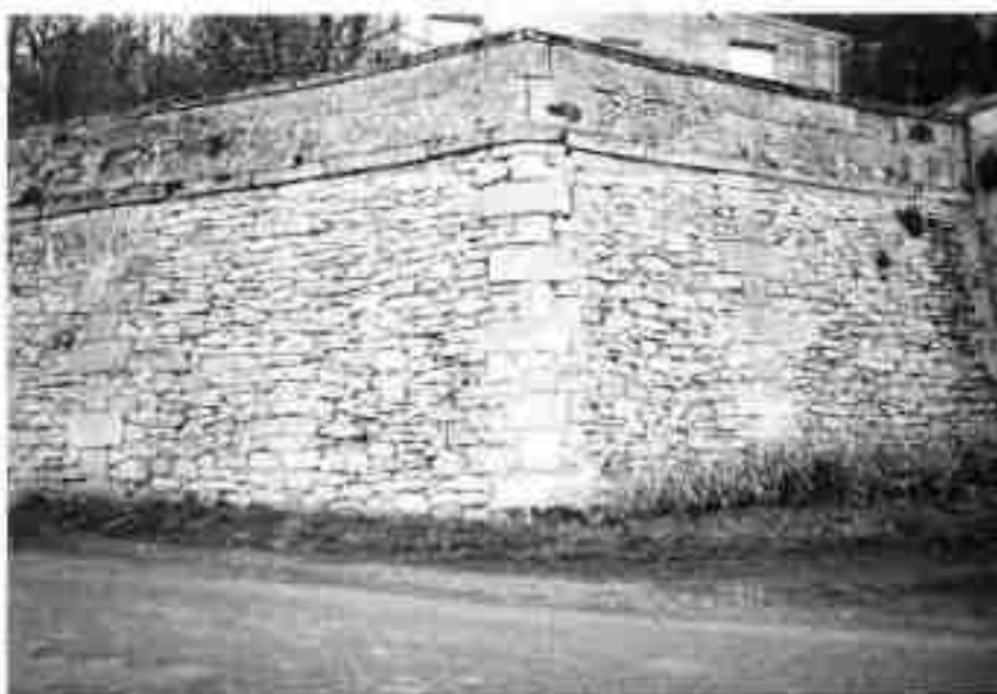
A - mur de soutènement construit en pierre sèche à Soucy ▶
