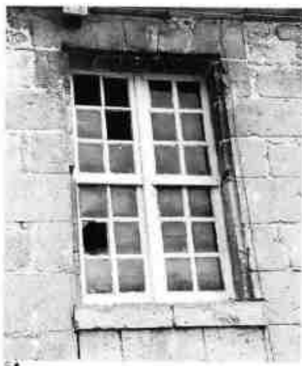
C - fenêtre à guillotine du XVIII e siècle. (ferme de la Rucole)
