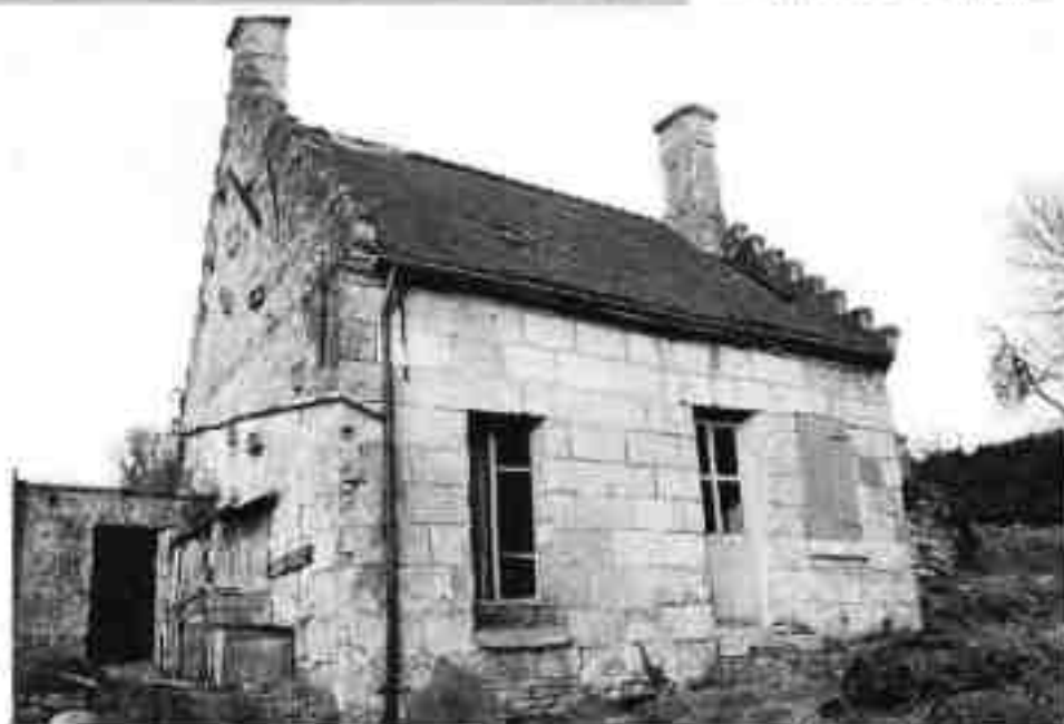
B - Lesges. ▶ La fenêtre a été agrandie.
