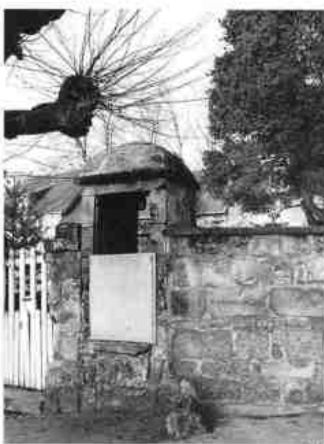
B - Vic-sur-Aisne puits à deux accès.
