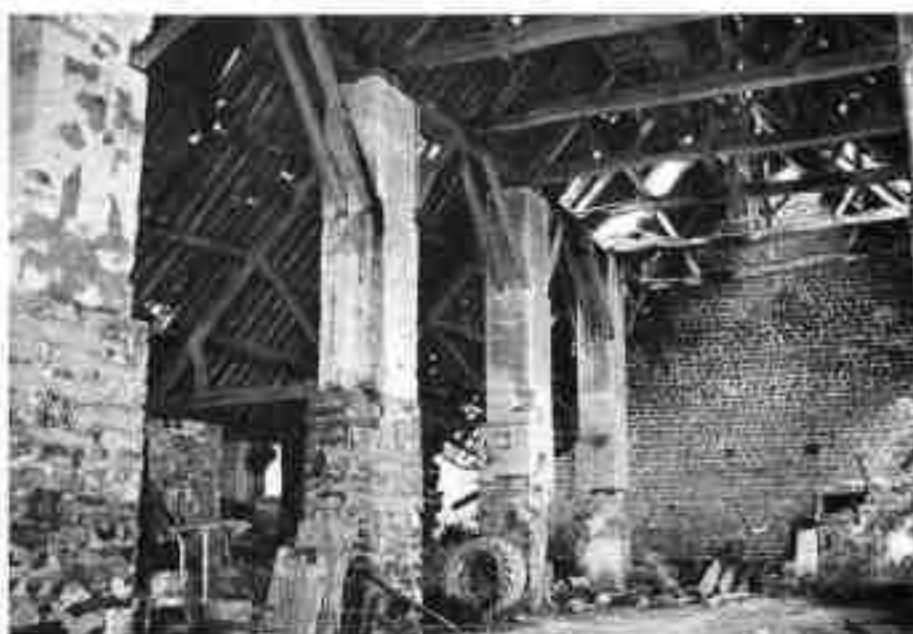
E - Fronteny. Intérieur de la grange. La charpente est ici portée par des piliers supportant des poutres jumelées soulignées par des jambes de force ▶
