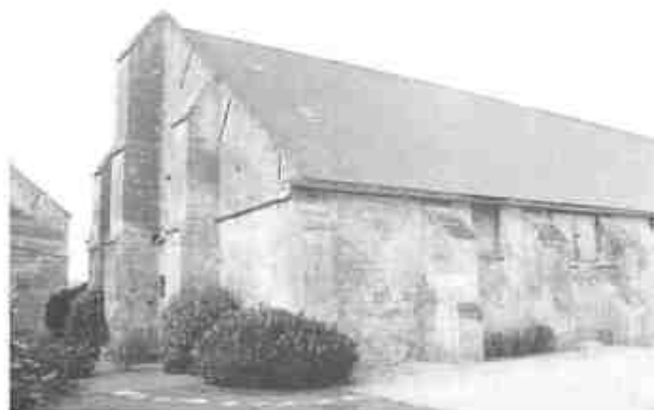
Mont-de-Soissons (Gerches, ordre des Templiers). La pointe du pignon a été abattue au XIX e siècle ← pour en réduire la pente.
