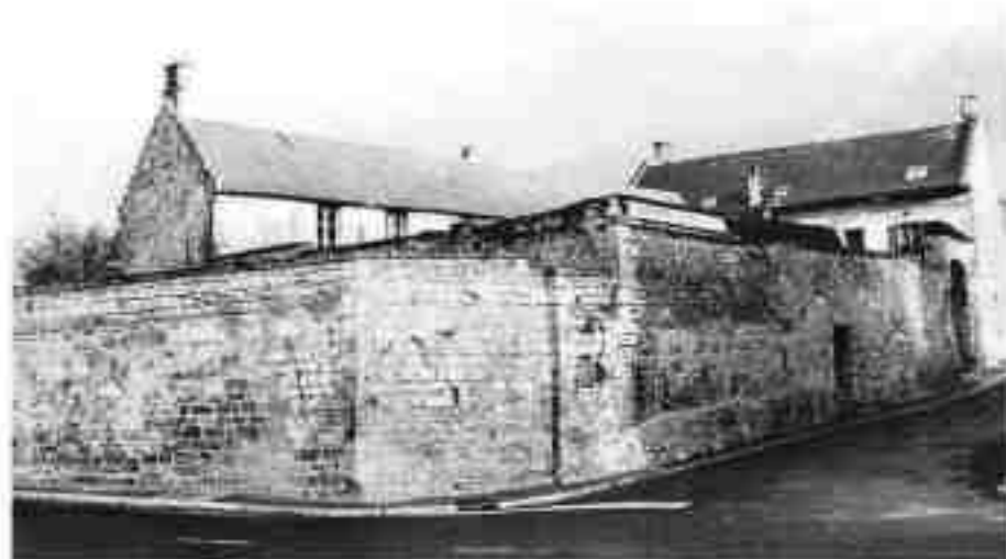
C - mur de soutènement donnant un aspect de forteresse à cette maison de vigneron ◀ de Billy-sur-Aisne.
