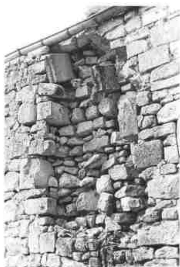
24 - Mur en pierres sèches.
