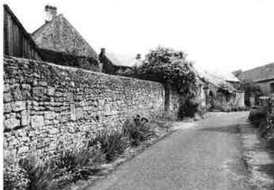
A - mur de soutènement construit en pierre sèche à Soucy ▶
