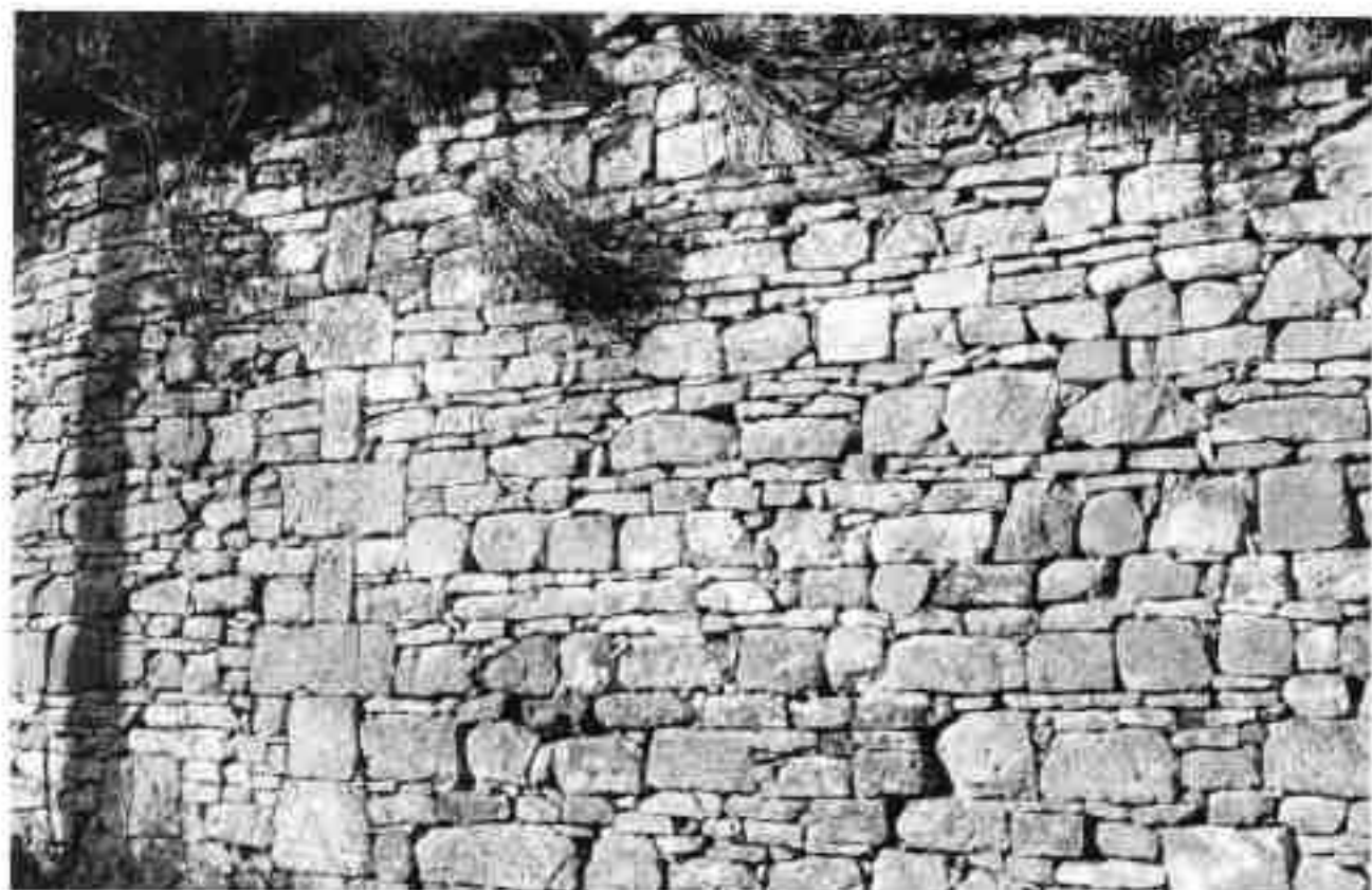
27 - Mur en pierres sèches renforcé d'une chaîne en pierre de taille à Montgobert.
