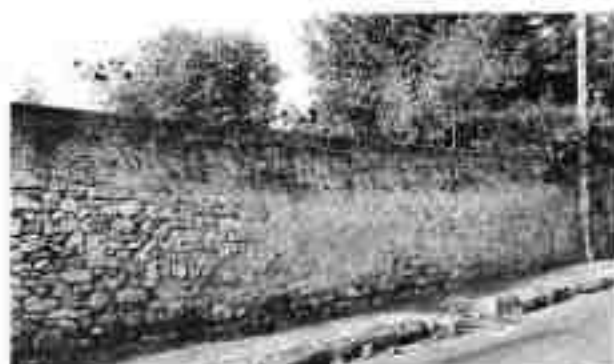
18 - Vieux mur de clôture à Cœuvres.
