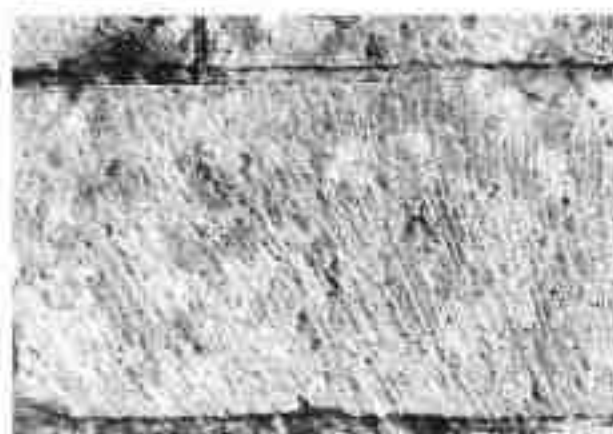
17 - Traces laissées par le marteau taillant.
