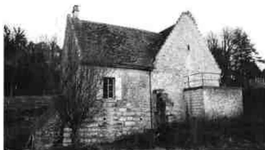
▶ B - Moulin de Montgobert. La roue se trouvait dans le massif de maçonnerie situé à droite.
