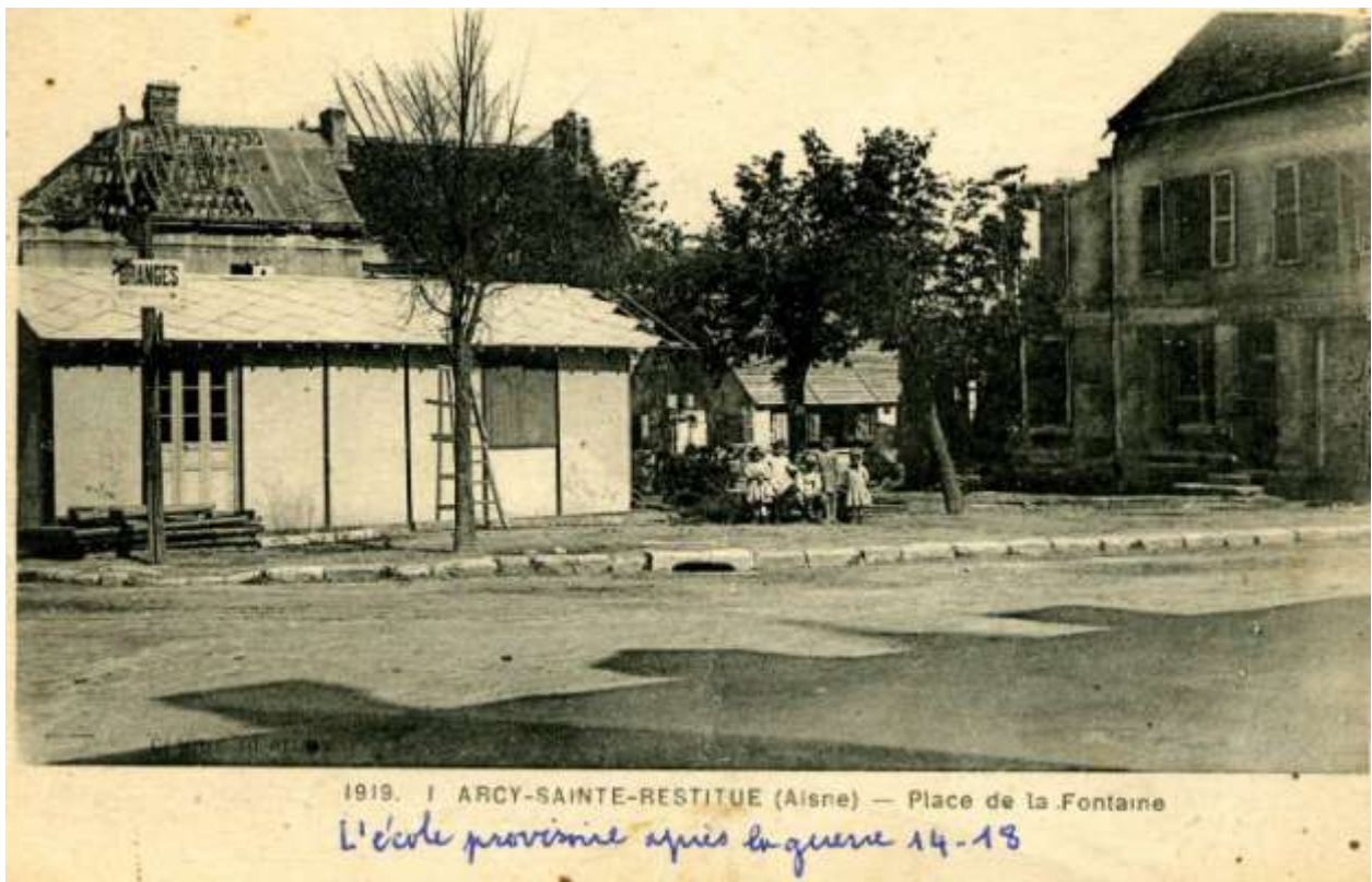
Ecole provisoire des garçons ; le toit du lavoir est déjà bien restauré permettant aux laveuses un retour à la normale ; à côté, la façade sans toit de la maison des Cerveaux atteste encore de la violence des bombardements surtout de ceux de l'offensive de 1918.
