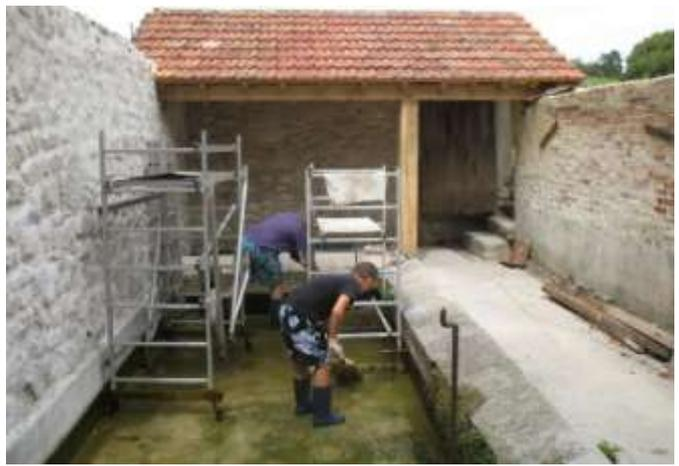
Le chantier reprend : Pose des rives, des noues en zinc par le maître André, faîtage du mur, nettoyage du bassin par Denise et Vincent, ciment des solins, le ciment des bords du lavoir, repose des 2 portes après réparation des ferrures, traitement bois, bref des finitions qui semblent n'en plus finir !
