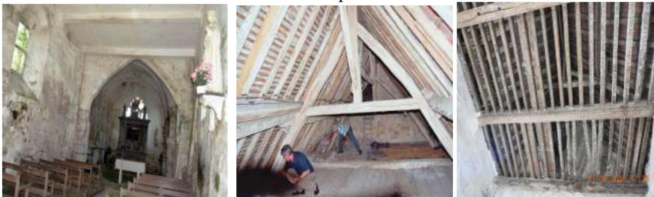
Les travaux de M. MOZIN ont permis d'analyser les murs, leurs rehauts et les éléments de la charpente, poutres ou fermes réutilisées ou bien doublées, confirmant ainsi qu'à l'origine de l'église, seule existait la construction de l'espace qui est l'actuelle nef. Le toit en était d'un seul pan en pente côté Nord vers la rue principale du village.
