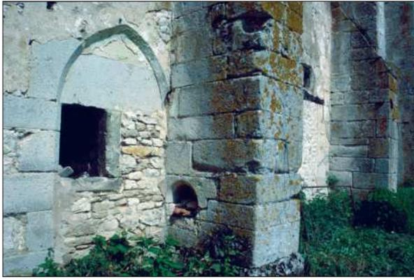
Fig. 12 – Montaon, détail de la porte principale du premier niveau du bâtiment médiéval, avec niche-bénitier dans le flanc du contrefort (photo C Corvisier).
