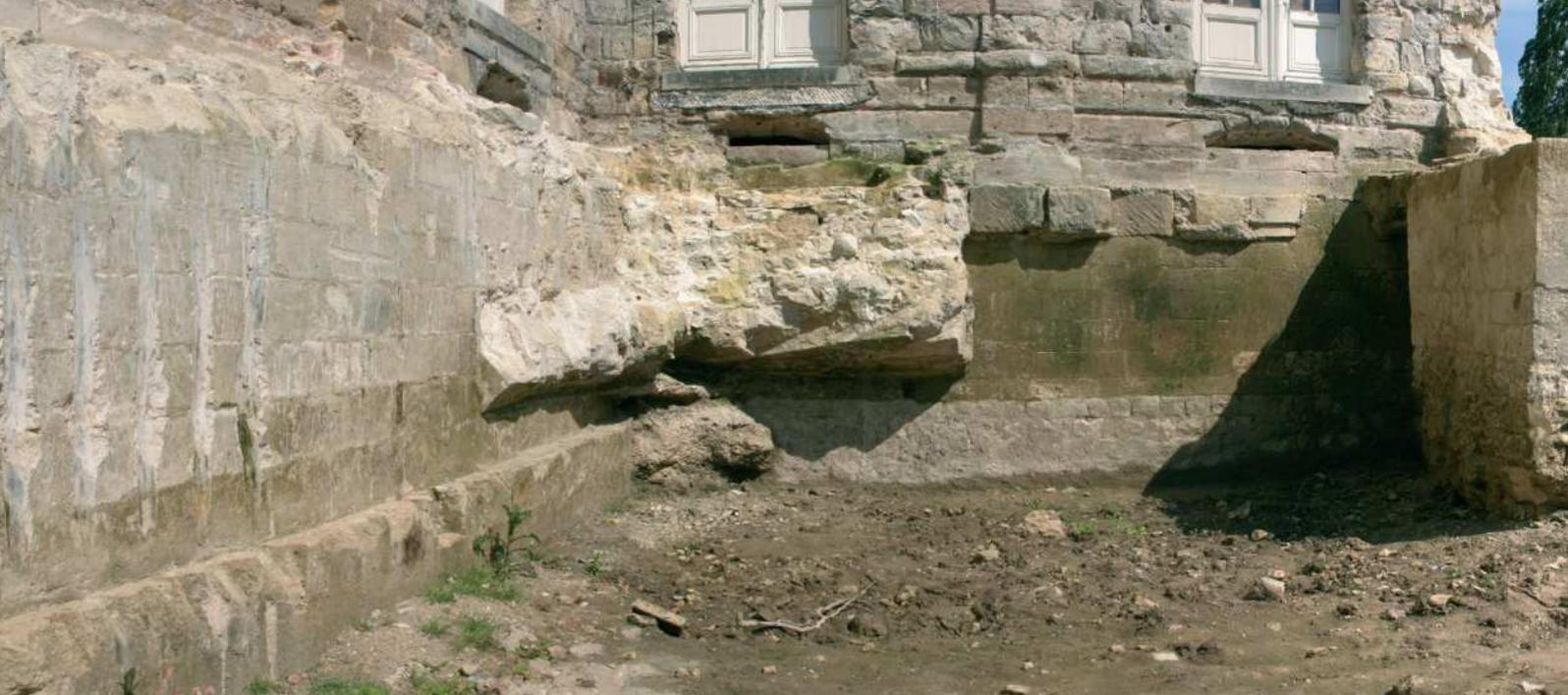
Vue panoramique. A gauche le massif de maçonnerie encastré dans le soubassement. A droite la première travée du pont dormant. La seconde est masquée par le mur de soutènement qui a réduit la largeur du fossé. Elle est traversée par un égout ou aqueduc.
