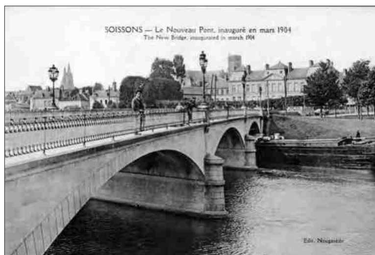
Le nouveau pont du Mail.
