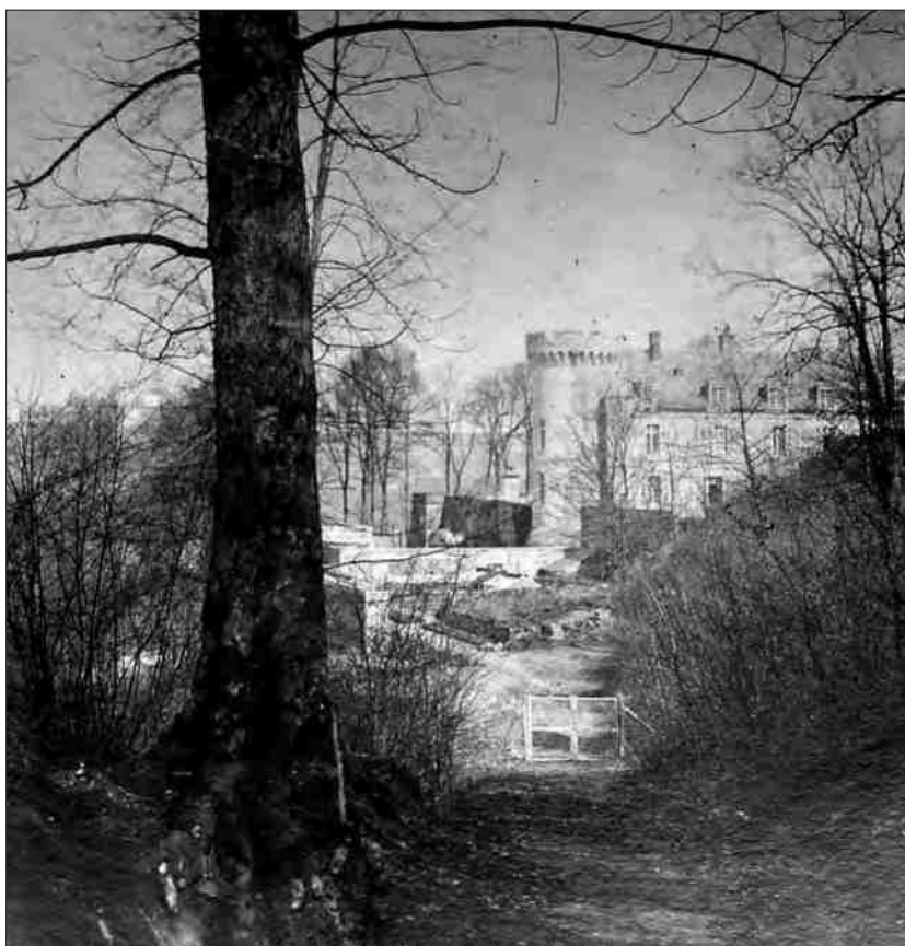
Fig. 1 Le château vu du parc, au sud /sud-ouest en 1913 (Photo Coll. Louvencourt – de Vanssay).
