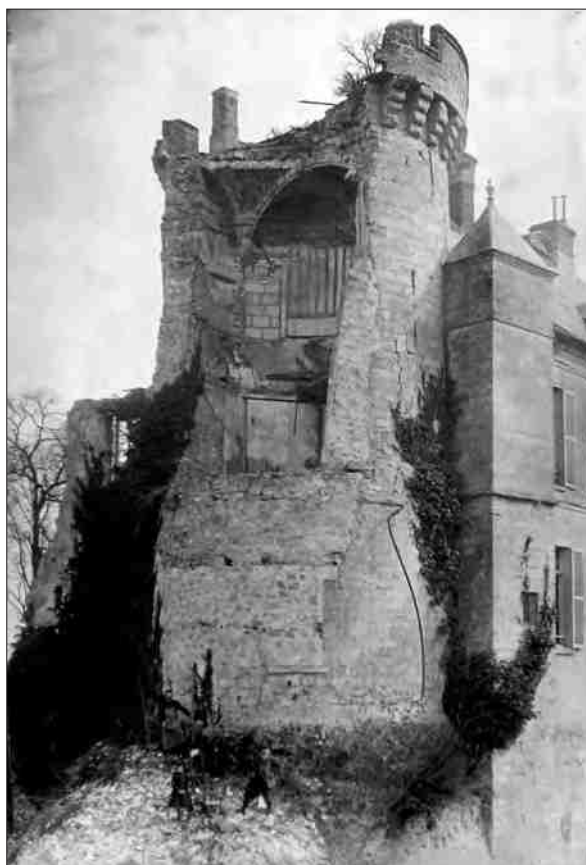
Fig. 11 Vue ouest de la tour sud-ouest du château en partie écroulée, vers 1911. (Photo Coll. Louvencourt – de Vanssay).
