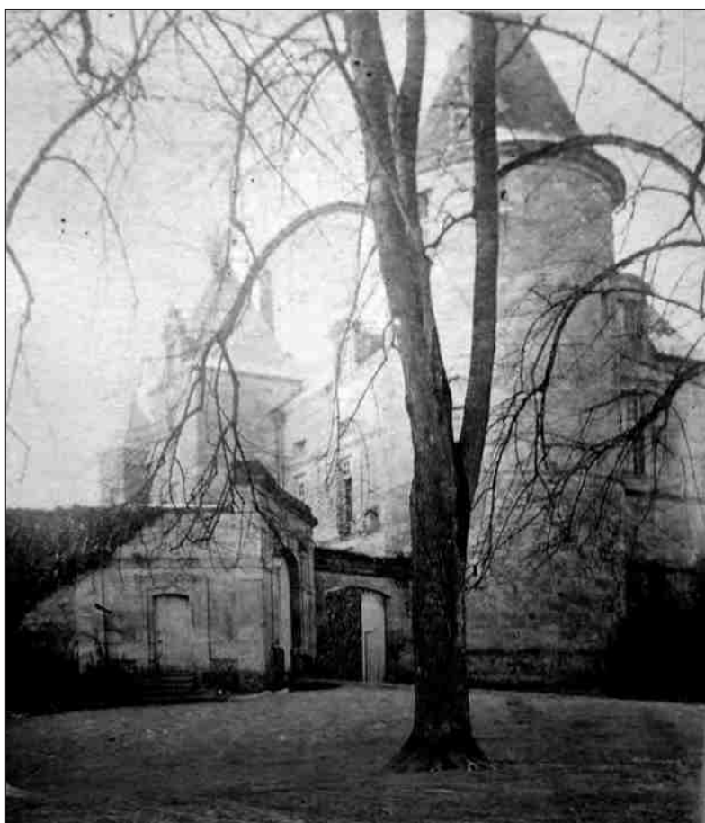
Fig. 28 Portails vers l'esplanade et vers le fossé, tour nord-est et façade est du château vers 1913 (Photo Coll. Louvencourt – de Vanssay).
