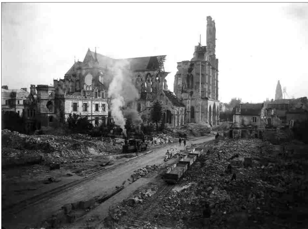
Le déblaiement des ruines.
