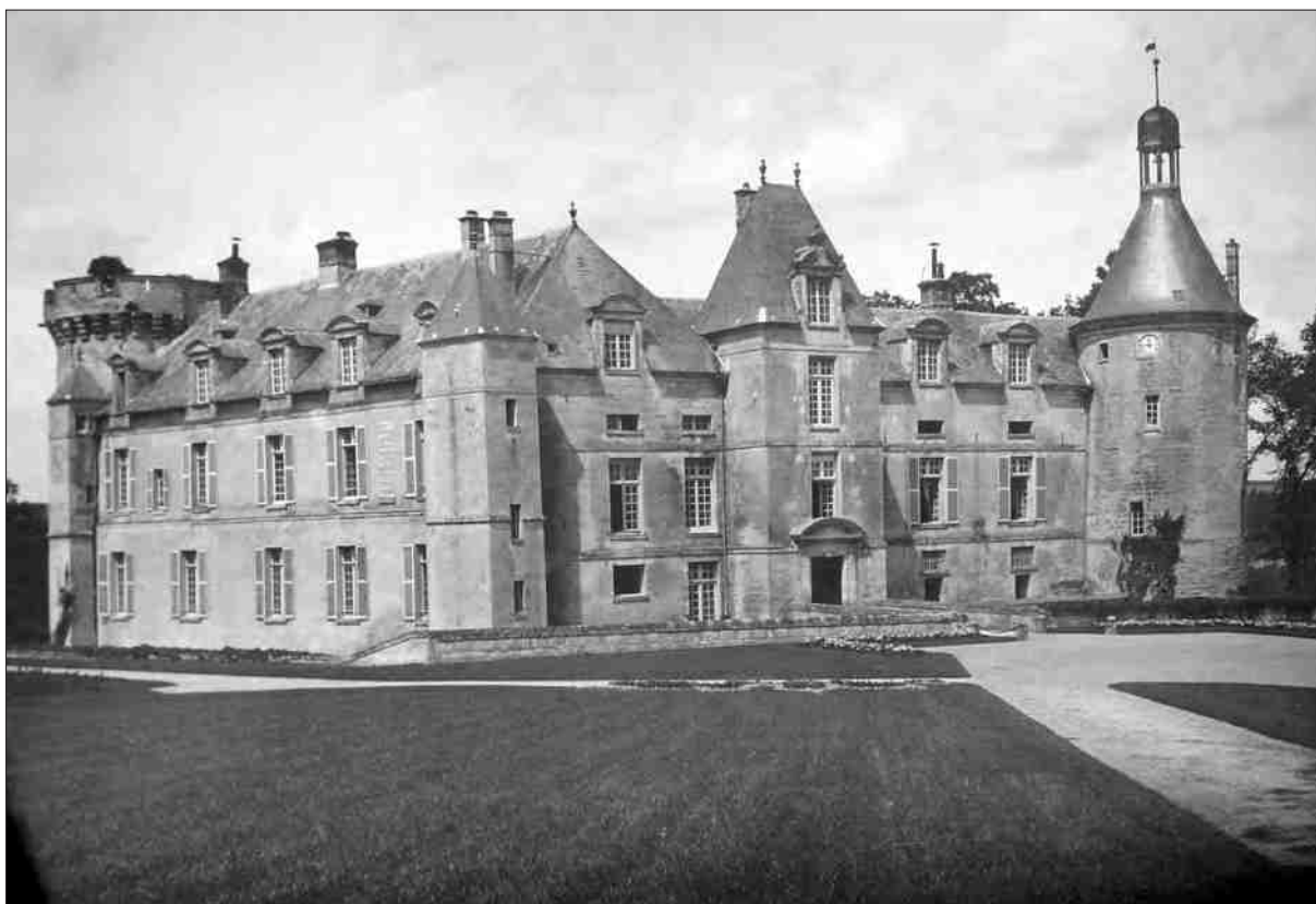
Fig. 8 Vue générale est/sud-est du château en 1912 (Photo Vergnol).
