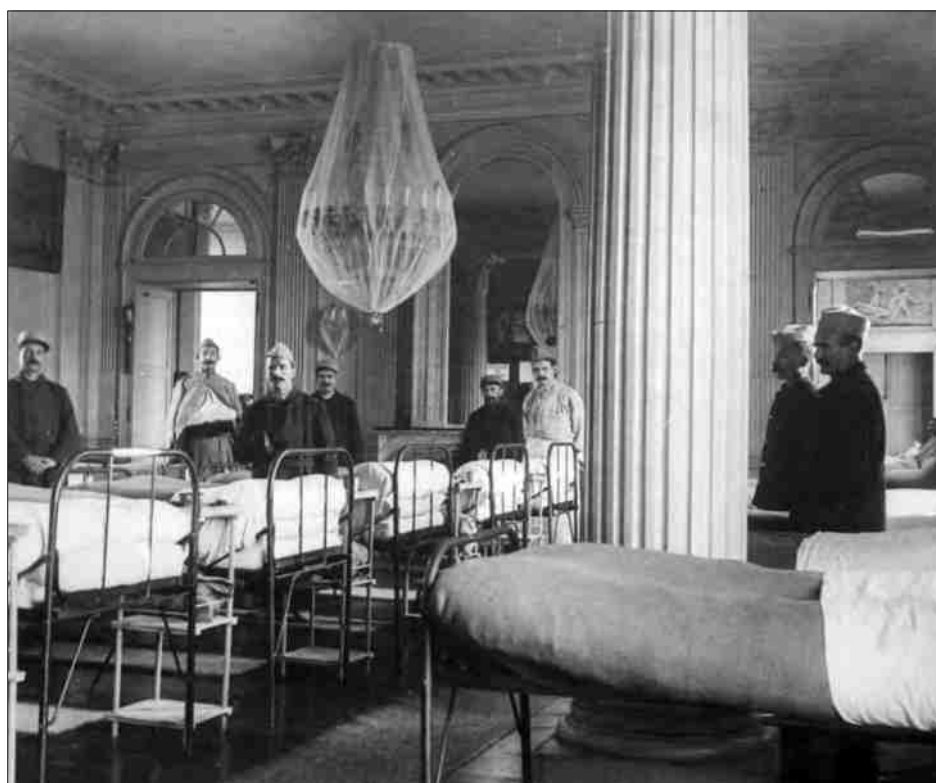
Fig. 32 La grande salle à colonnes au bout du rez-de-chaussée de l'aile sud au temps de l'hôpital militaire, vers 1915 (Photo Coll. Louvencourt – de Vanssay).
