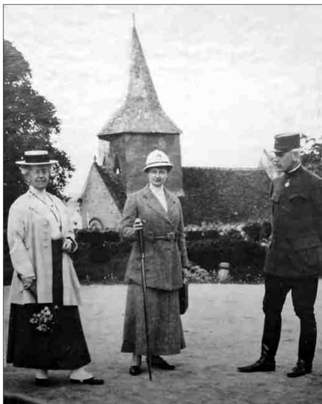
Fig. 5 Mademoiselle Nadège de Louvencourt sur l'esplanade du château de Muret au temps de l'hôpital militaire, entre sa dame de compagnie et le général Baquet ; au fond, l'église vers 1915 (Photo Coll. Louvencourt – de Vanssay).
