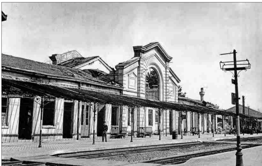
La gare après l'explosion d'un train de munitions américain.
