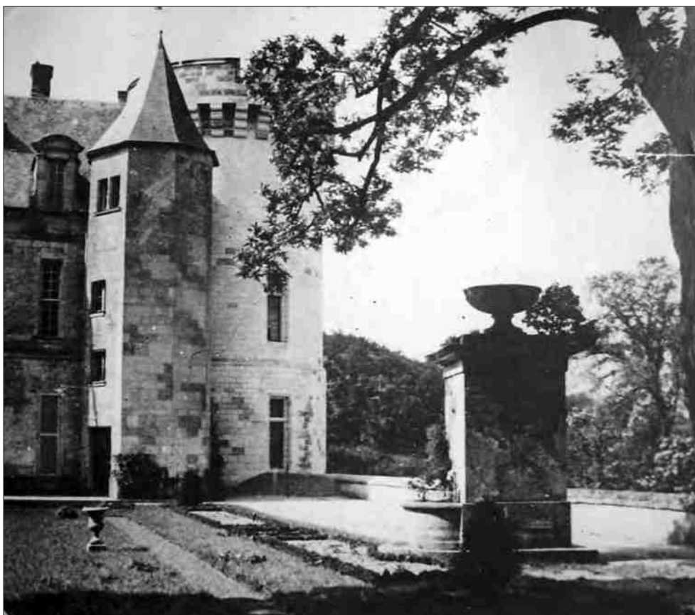
Fig. 14 La tourelle d'escalier de l'aile sud et la tour sud-ouest du château de Muret après restauration, vers 1913 (Photo Coll. Louvencourt – de Vanssay).
