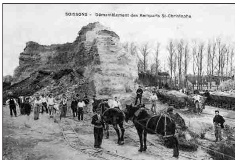
Démantèlement des remparts.
