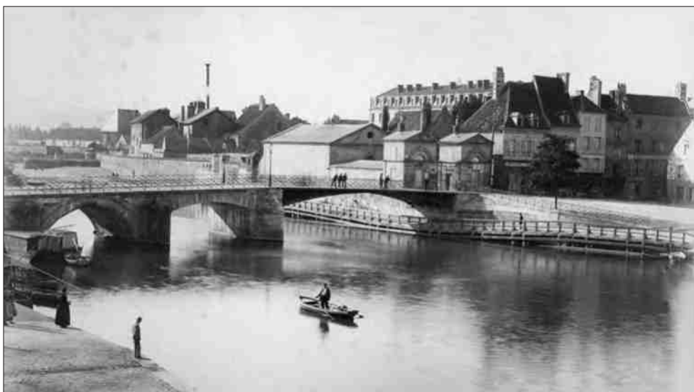
Le pont avec la nouvelle arche métallique construite après 1894. A l'arrière, l'ancienne bourse aux blés.
