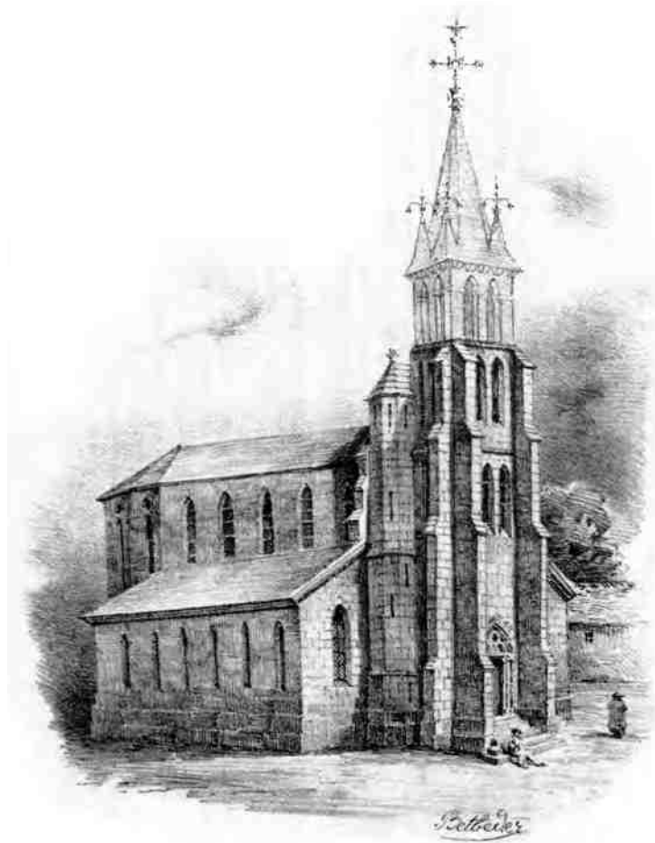
La nouvelle église Saint-Waast.
