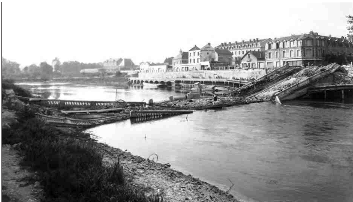
Pont détruit en 1940.
