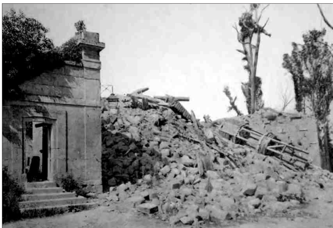
Fig. 4 Décombres de la tour nord-est et de son lanternon, même angle que la fig. 3, en août 1918 (Photo Coll. Louvencourt – de Vanssay).
