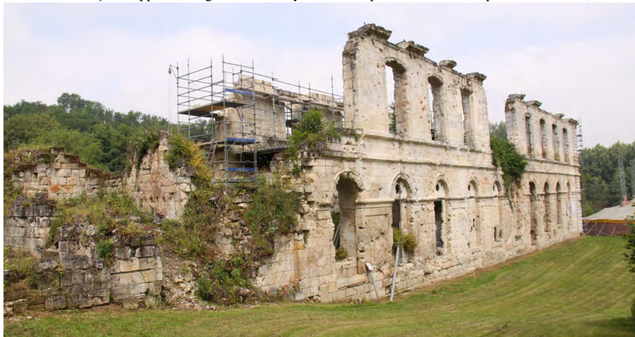
L'abbaye de Valsery en cours de restauration
